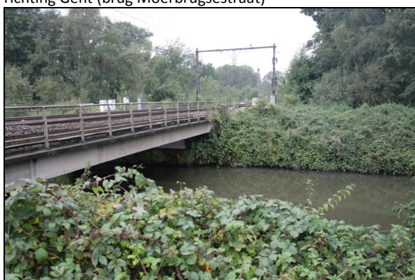
Ter hoogte van overbrugging Rivierbeek
