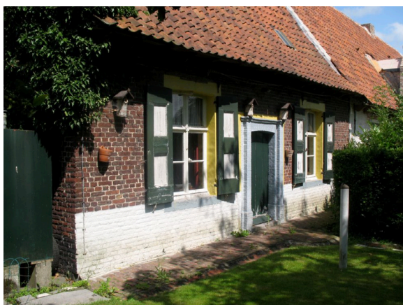
Oude situatie - zoals gedocumenteerd op Vastgestelde Inventaris Bouwkundig Erfgoed (website geconsulteerd op 16/02/2017)
